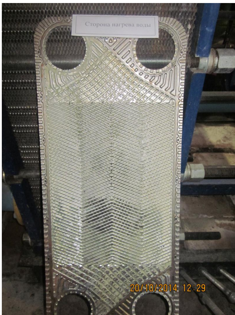
Рис. 2 – Состояние пластины после очистки
